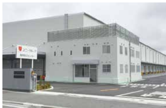
ユニーグループ静岡物流センター
