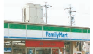
複合冷凍機(室外機)
