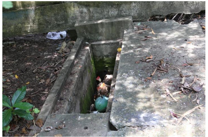
Binh Phuoc 小学校の分校の校舎。トイレ、手洗い場の水道管が度重なる浸水で壊れ、そのままになっている。校舎内にある溝がトイレとして代わりに使用されており、不衛生である。
