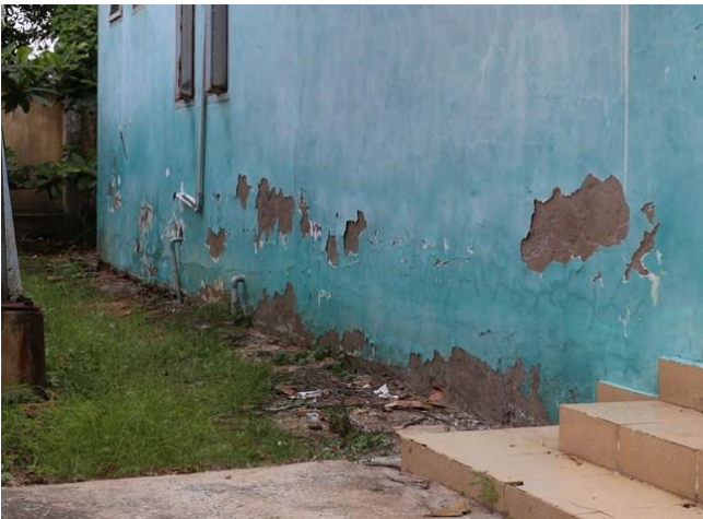
Binh Phuoc 小学校の分校の校舎。度重なる浸水で傷みが激しい。
