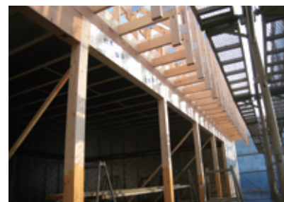
木造FP工法(建築中の店舗入口)
