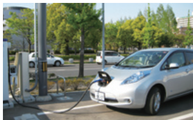
電気自動車の急速充電器を設置
