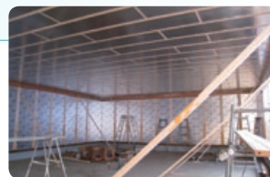
建設中の店内
