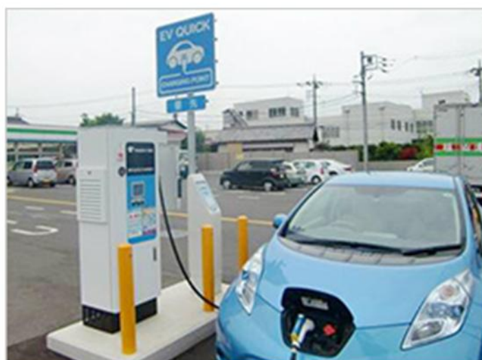
電気自動車の急速充電器を設置
