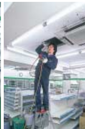
冷凍機(左)、空調機(右)などに封入されているフロンガスを3~4時間かけて回収します
