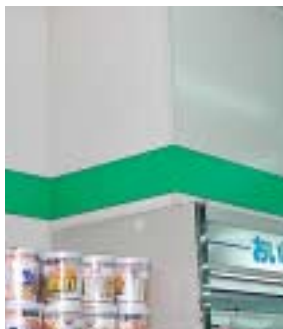
アルポリック使用の売場内壁(下り壁)
