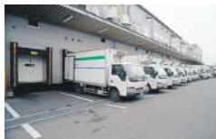
チルド庫のドッグに2室式車輛が後部を接続。ドッグの周囲には45mmのラバーが取り付けられ、庫内への外気の侵入を防いでいる
