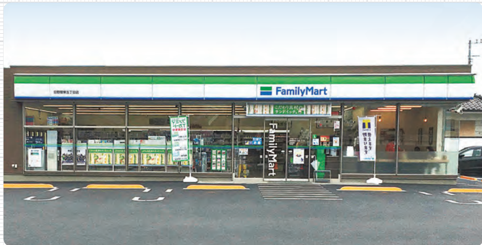
実証実験を行っている省エネ型店舗
