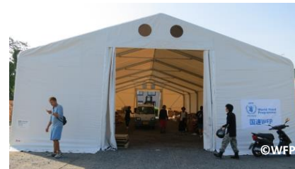
益城町に設置された大型可動式倉庫
